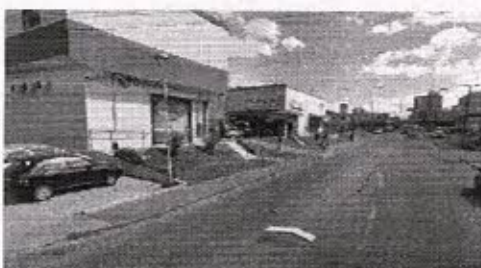
Fig. 02: vista geral Av. das Araucárias (Google)
