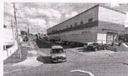
Fig. 03: vista geral Rua Jaquetibá (Google)
